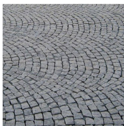
dlažba z běžných žulových kostek
